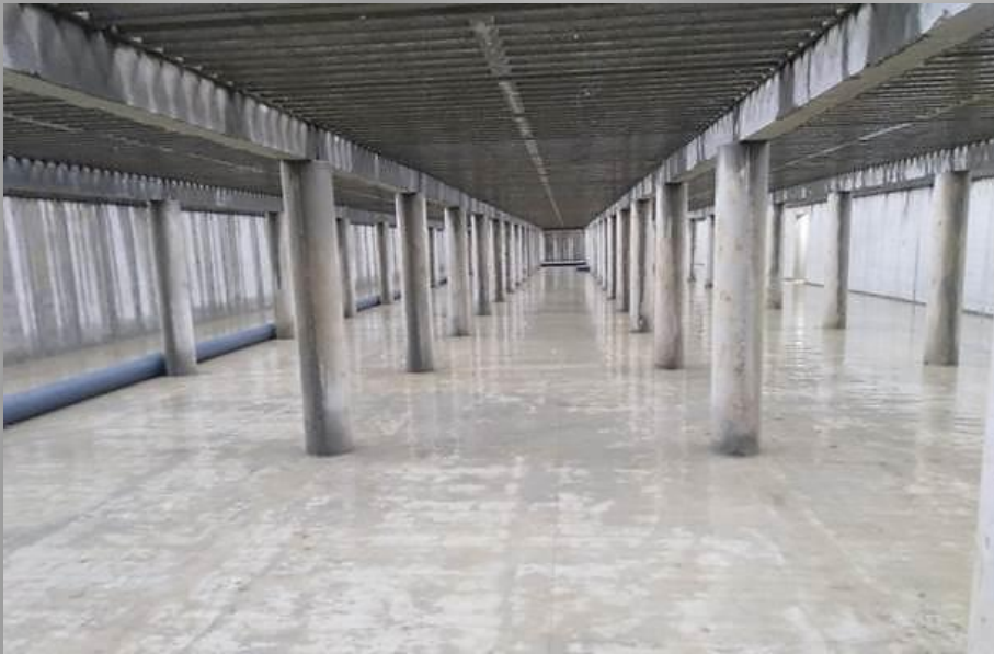
Рис. 1 Глибока ванна для зберігання гною
