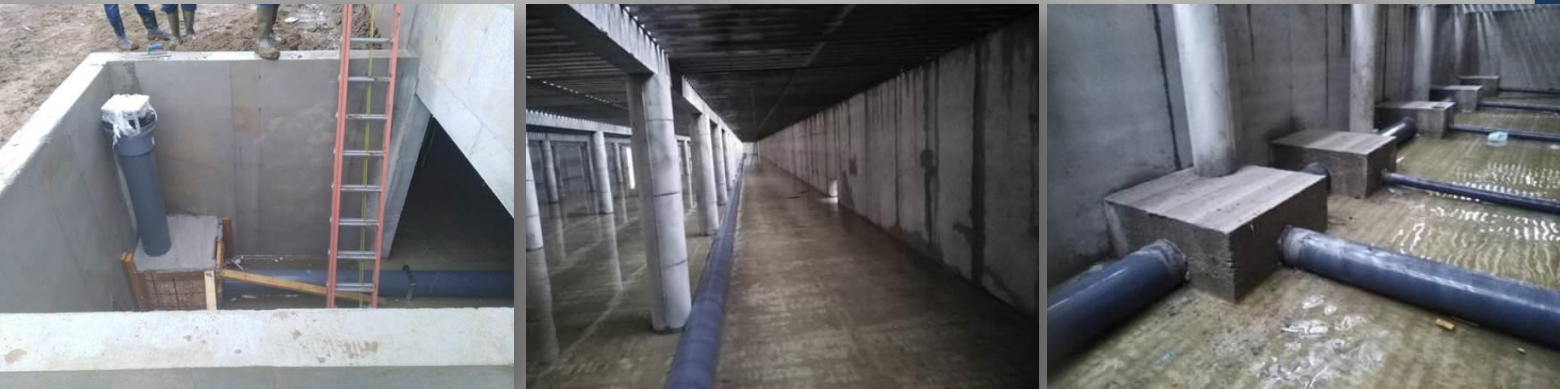
Рис. 6 Конструкція глибокої ванни з одним прямком та розгалуженою системою труб
