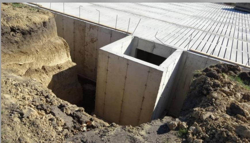
Рис. 3 Приямки для відкачування гною та під-підлогової вентиляції
