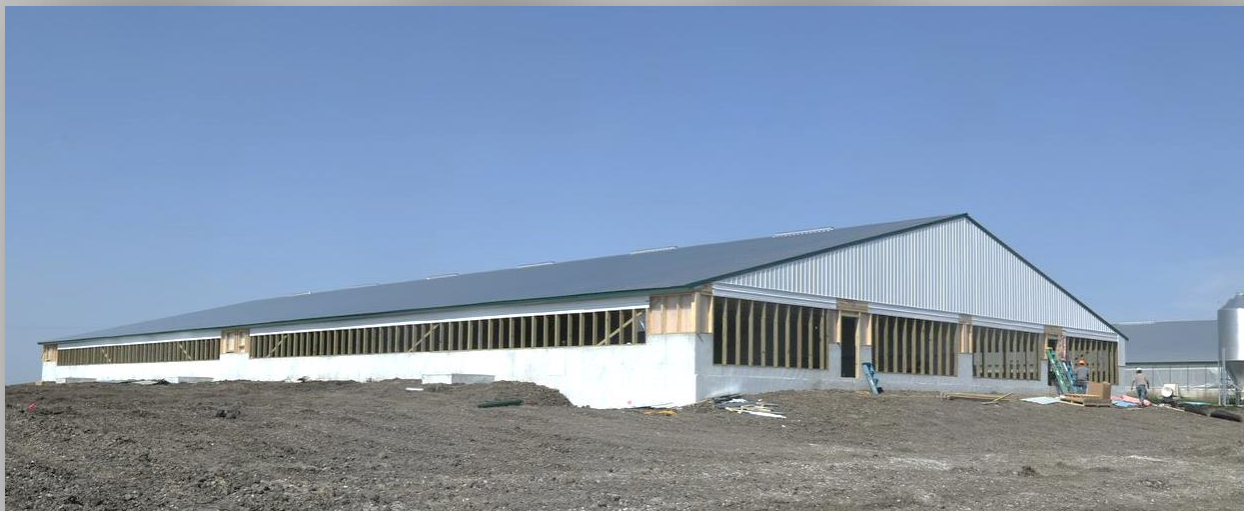
Рис.4 Вигляд ферми для відгодівлі – до монтажу обладнання та заселення порослят.
